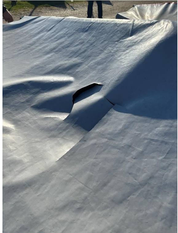
Figur 17: Presenning ødelagt i styrbord side.
